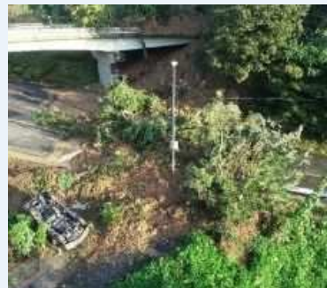
県道鳥取鹿野倉吉線(鳥取市御熊) の被災状況
