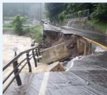
国道373号(智頭町福原) の被災状況
