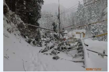
電柱倒壊の状況 (八頭町姫路)
