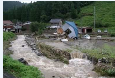
若桜町寺所(角谷川)の被災状況
