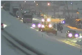
国道 9 号における除雪状況
