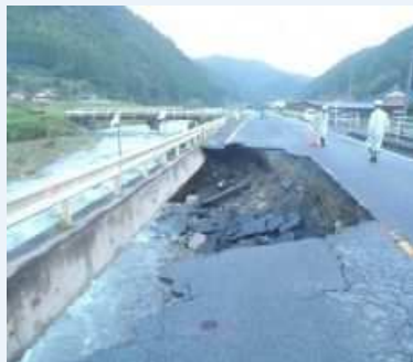
国道180号(日野町濁谷) の被災状況
