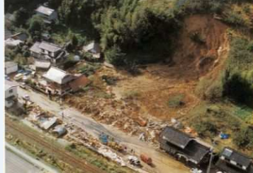
湯梨浜町方地の斜面崩壊
