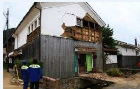
白壁土蔵群の建物被害
