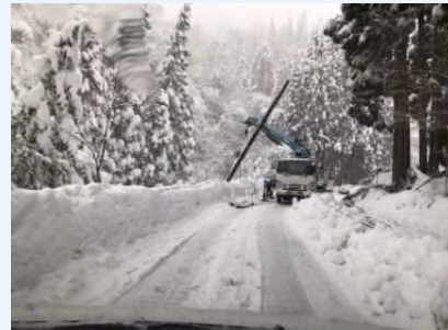
復旧作業の状況 (若桜町来見野)
