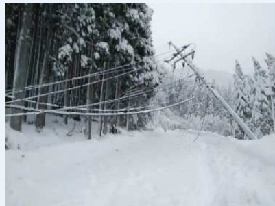
電柱倒壊の状況 (若桜町来見野)
