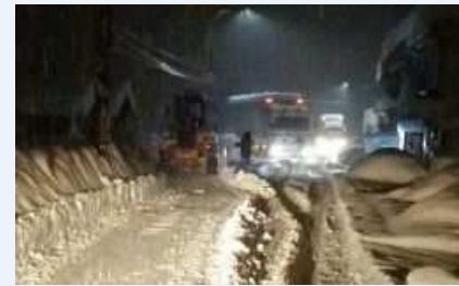
国道 373 号(智頭町大内地内)の除雪状況
