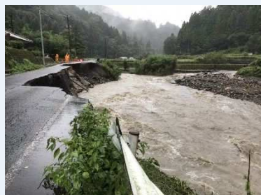
国道482号 (鳥取市佐治町尾際) の被災状況
