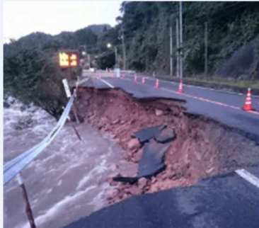
国道179号(三朝町久原) の被災状況
