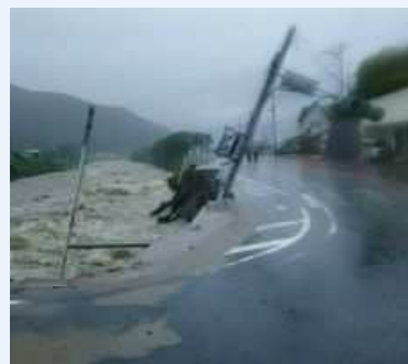
国道373号(智頭町南方) の被災状況
