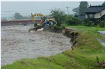
米子市河岡(佐陀川)の被災状況
