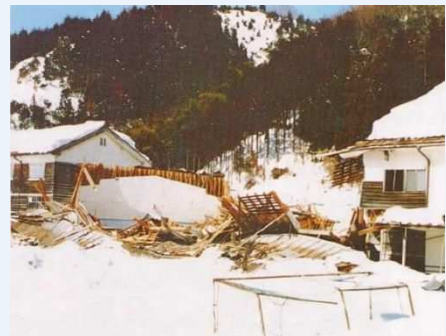
雪の重みで全壊した成器小学校体育館 (鳥取市国府町)
